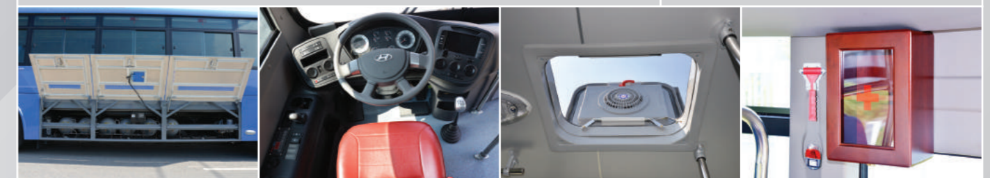
Hệ thống gas đảm bảo an toàn khi vận hành
